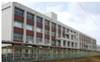
耐震化の完了した校舎
